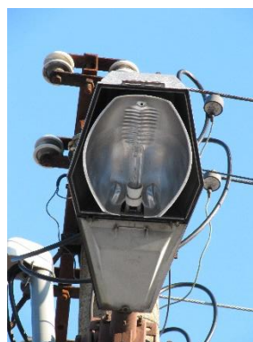
Obrázek 15: Elektrosvit 4441970 Sodíková výbojka
