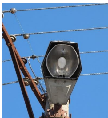
Obrázek 14: Elektrosvit 4441970 Rtuťová výbojka
